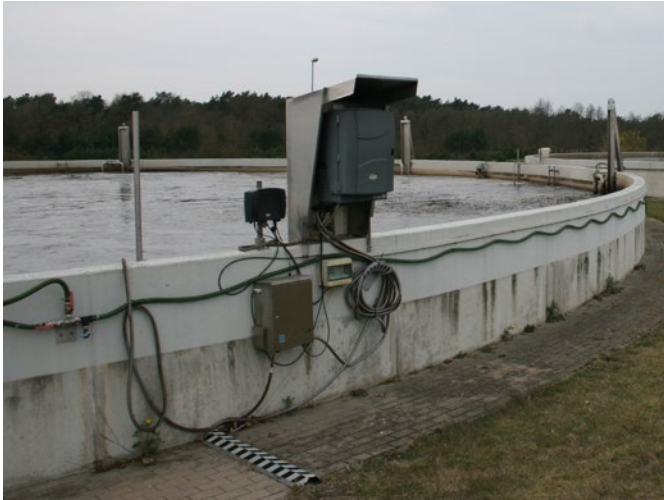
Abb. 2: Installation des zweikanaligen Phosphax sc am Beckenrand zusammen mit einer Filtrax Einheit.
