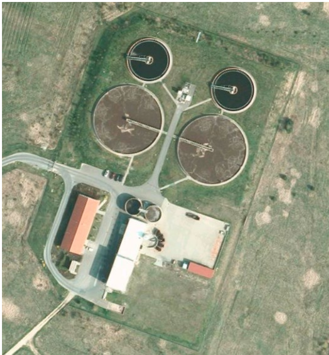
Abb. 1: Luftbild der KA Luckenwalde – gut zu erkennen sind die beiden großen Belebungsbecken und die zwei kleineren Nachklärbecken.
