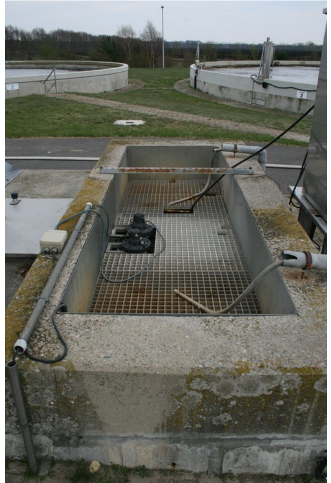
Abb. 3: Verteilerbauwerk mit der Dosierungseinrichtung im Zulauf.
